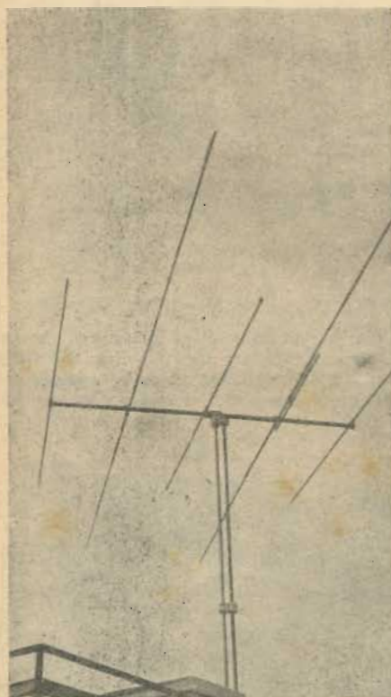
Antenna direzionale rotativa montata a 3 elementi per i 10 mt. e 2 elementi per i 20 mt.
